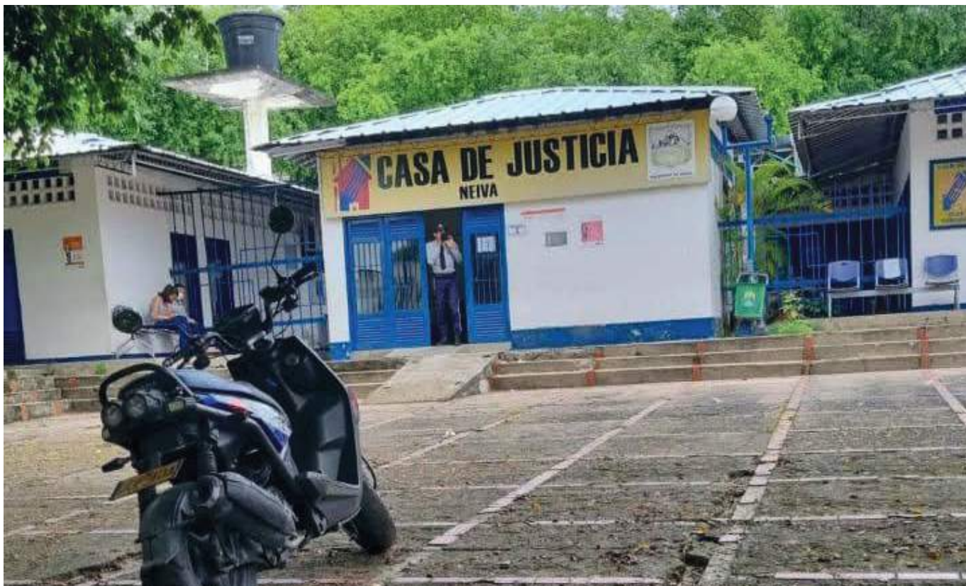
En la capital del departamento huilense, Casa de Justicia queda ubicada en el barrio Los Parques de la comuna 8.
