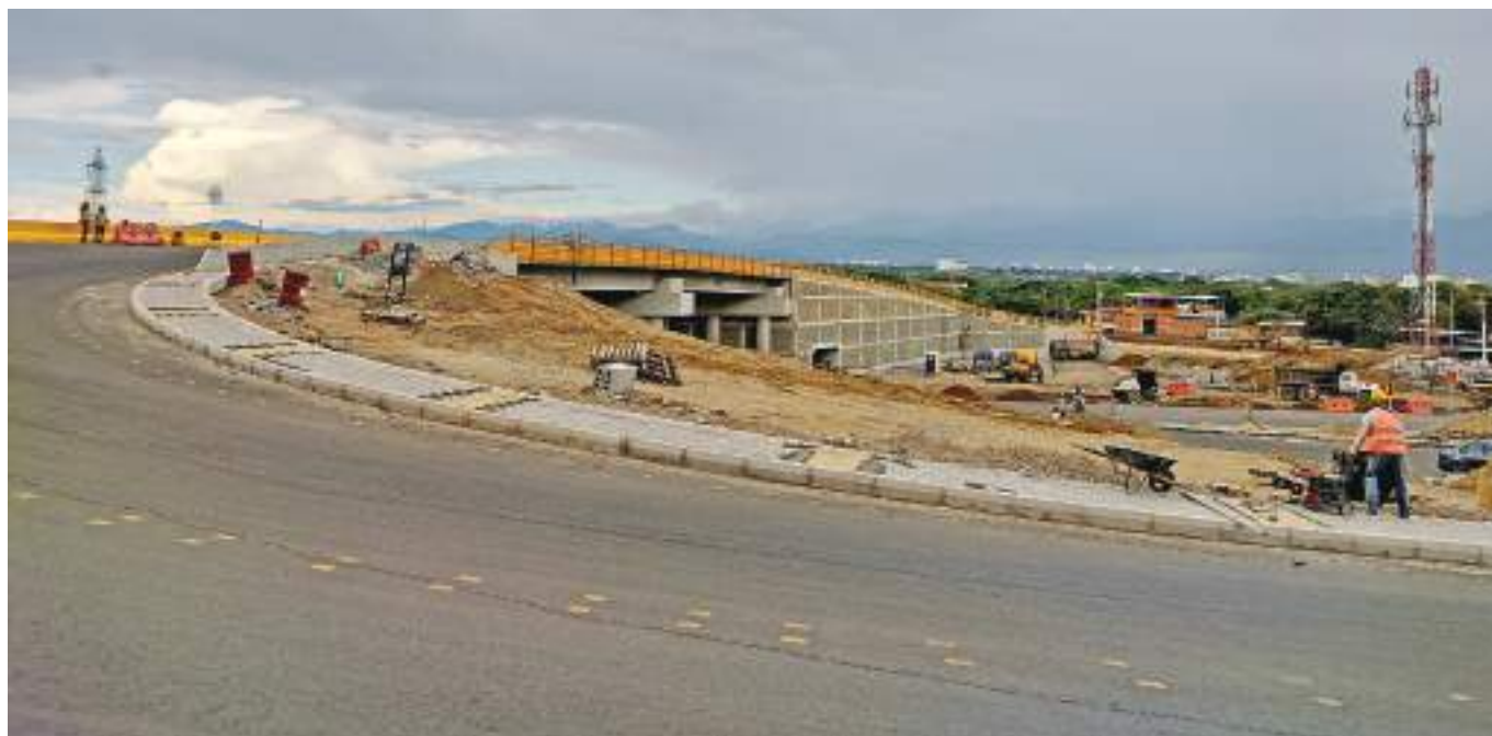
Se habilita el paso por el intercambiador El Triángulo.
