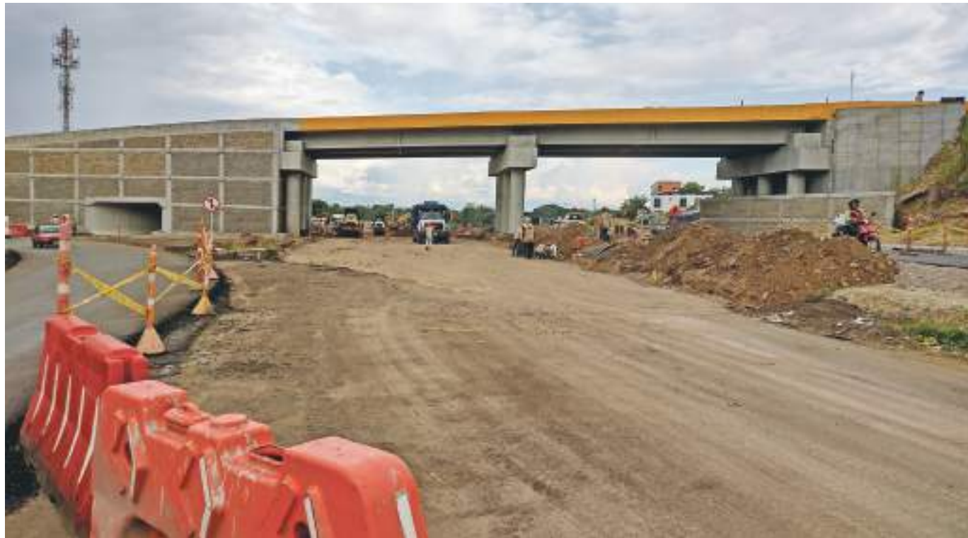
Todavía siguen realizando obras por debajo del puente.
