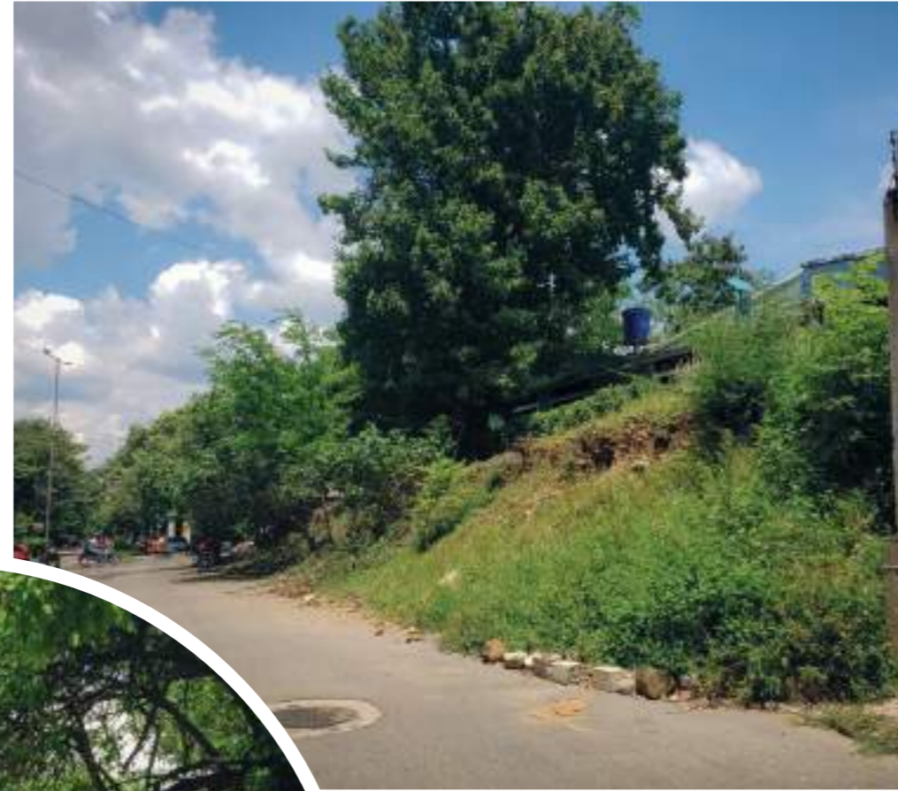
Las vías en mal estado y desechos que dejan habitantes de calle regados, causan accidentes.
