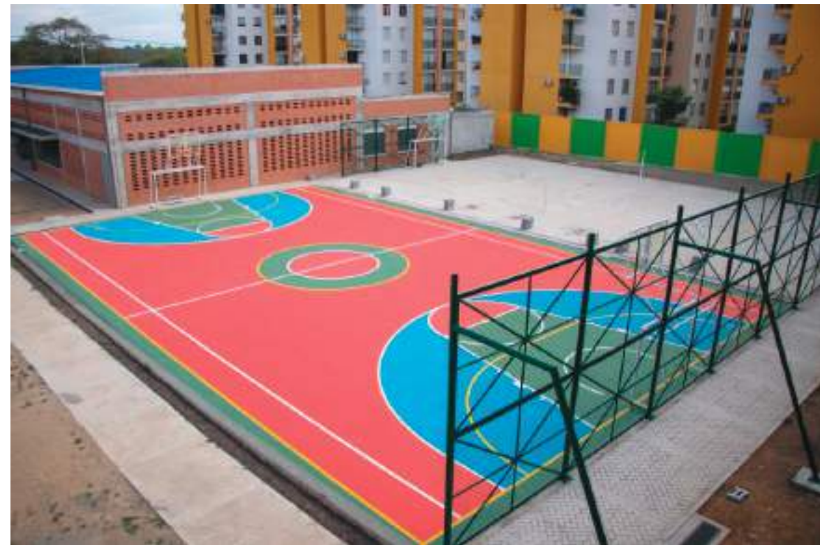
Panorámica en la que se aprecia el polideportivo y parte de la infraestructura construida de la institución educativa "Gustavo Torres Parra", en Neiva.
