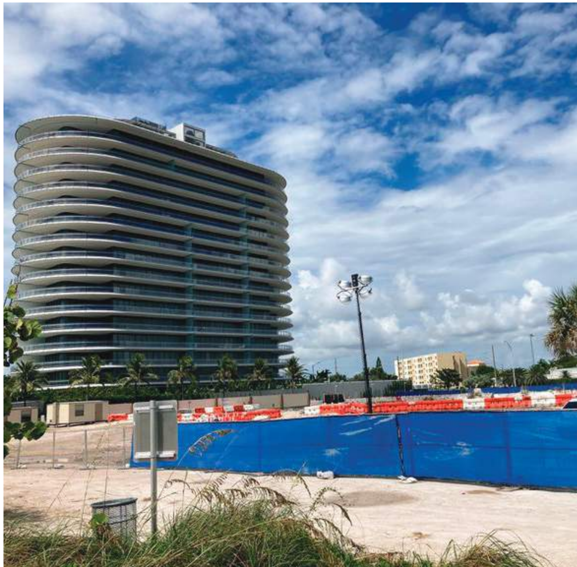
Vista del lugar en donde se encontraba el edificio que se derrumbó en Surfside, una pequeña ciudad de Florida (EE.UU.) aledaña a Miami Beach.
