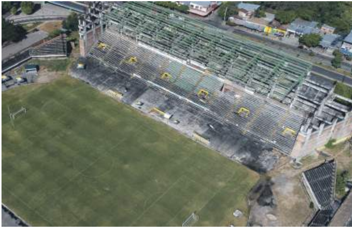
Según la administración actual esta será una de las obras que entregará terminada en el 2023.
