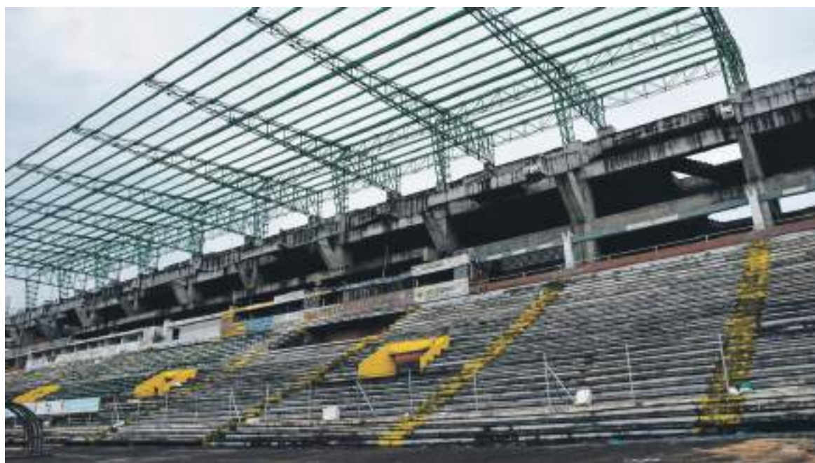
Entre las obras el encerramiento, fue uno de los ítems que incluyó la ejecución de los más de 1.100 millones de pesos.
