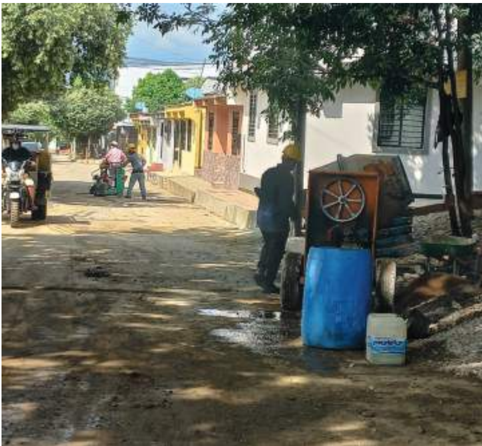
Mezcladora y otra maquinaria generadora de contaminación auditiva.
