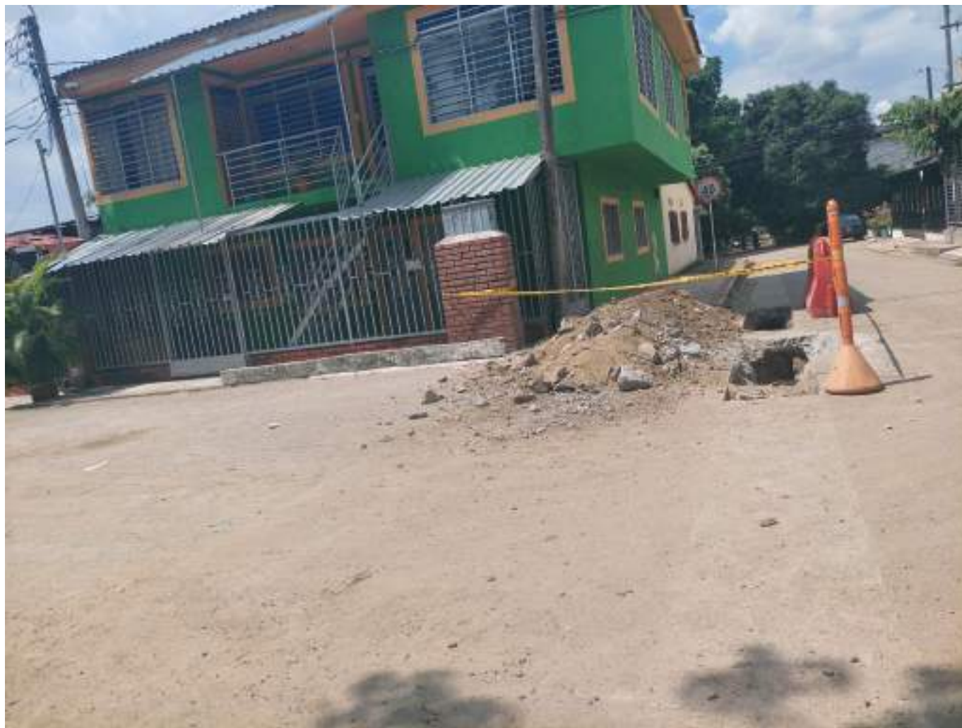
Brechas abiertas para las acometidas.
