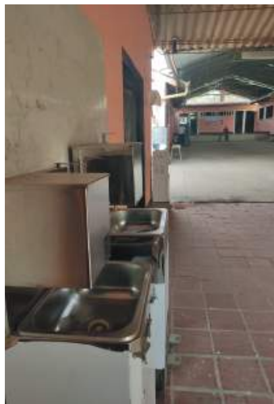
Así están terminando de deteriorarse los lavamanos portátiles en la I.E. La Victoria, que ya están en uso.
