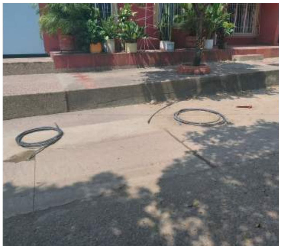
Materiales y desechos abandonados en el lugar.
