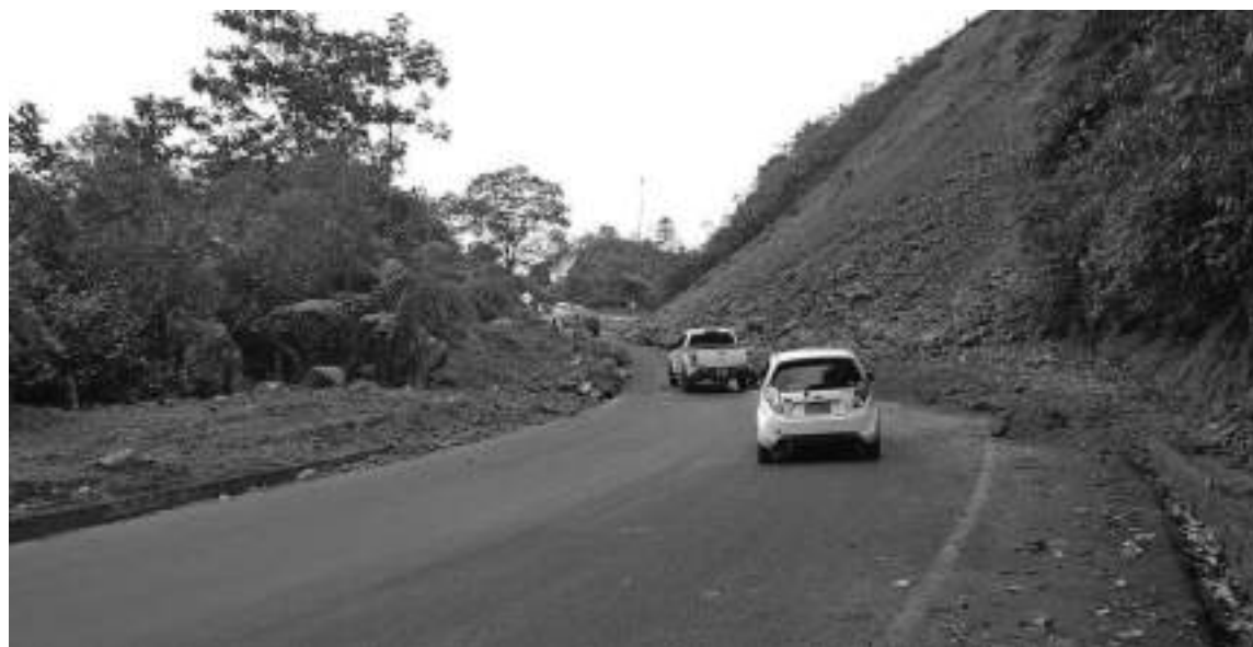
Habilitada la vía Suaza - Florencia, con un carril, en el tramo Depresión - El Vergel - Florencia en el kilómetro 54+0120.
