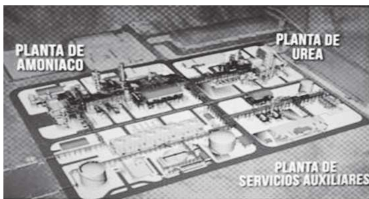
Planta de Amoniaco y Urea para la industrialización del Departamento del Huila (Municipios de Neiva, Aipe y Palermo)
