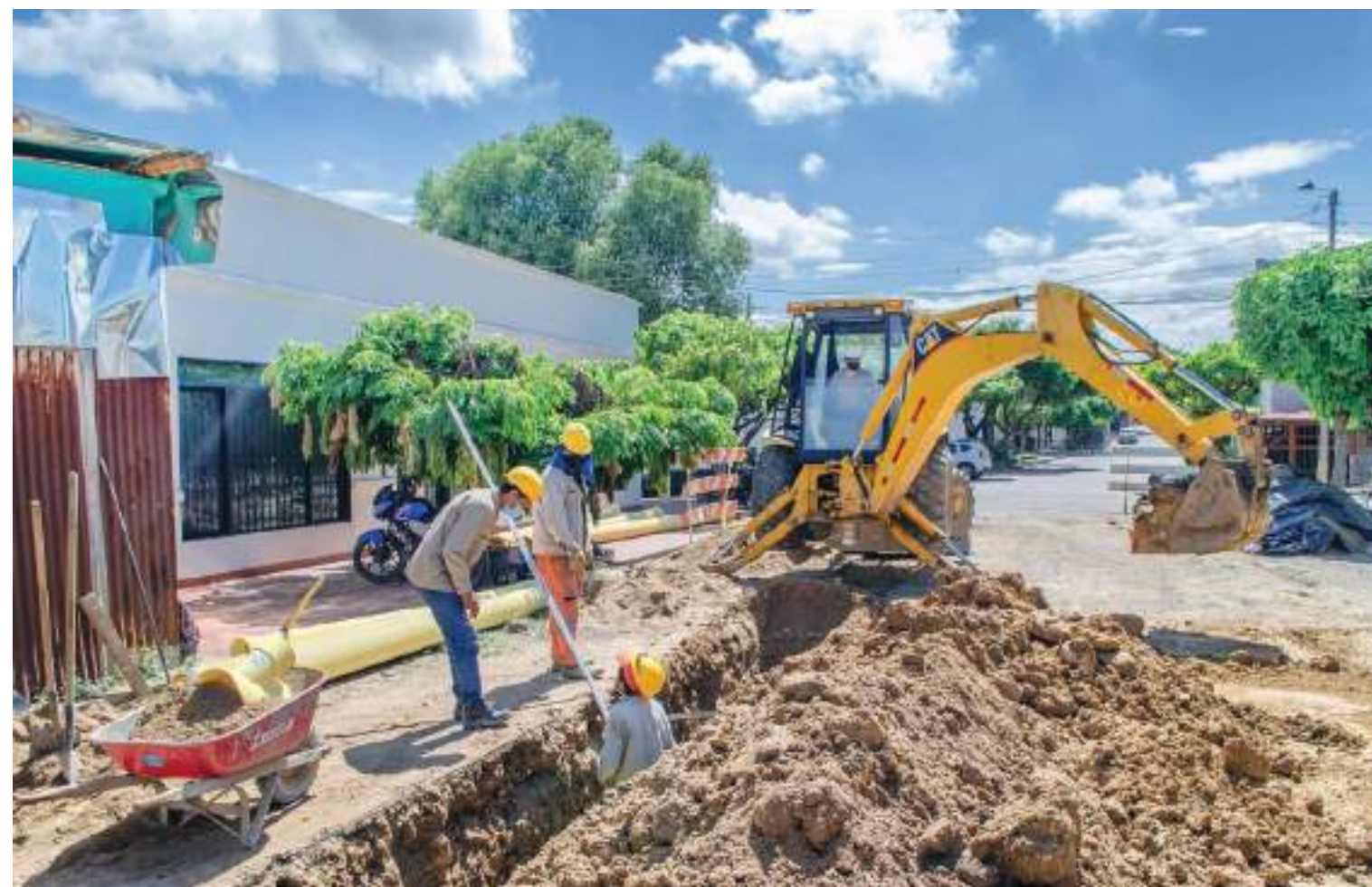
Operarios de las Ceibas realizando trabajos en las redes de agua.
