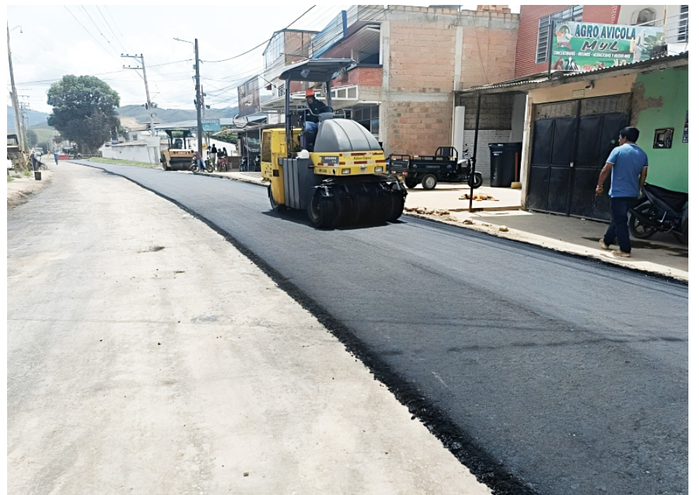
Rehabilitación de 3.32 kilómetro del corredor vial Pitalito - Palestina.
