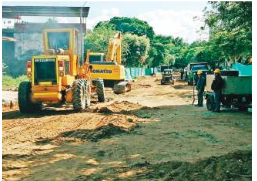
La pavimentación de la calle 51 en el barrio Álamos en Neiva, forma parte del paquete de proyectos de pavimentación urbana en el cual el gobierno departamental adicionó $1.900 millones, para que fueran terminadas cuatro vías, las cuales beneficiaran a diferentes barrios de la capital del Huila.
