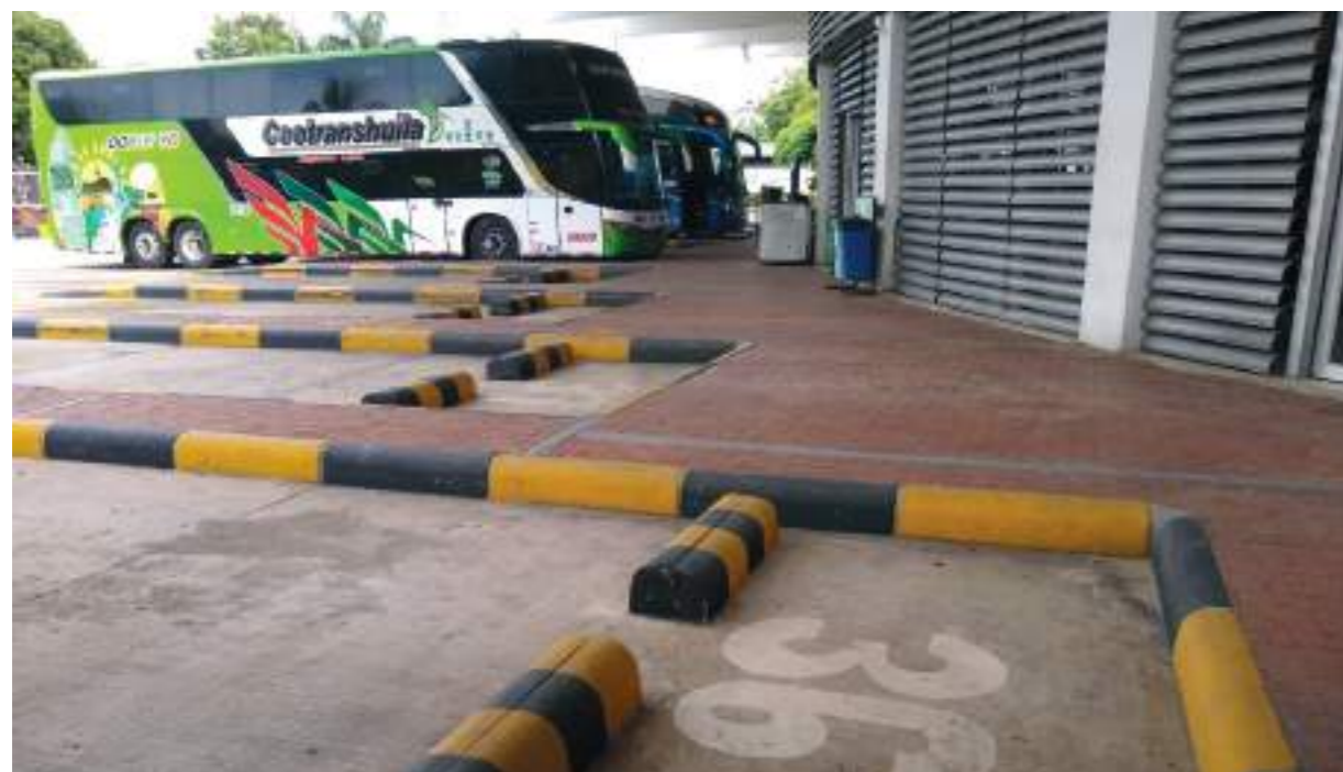
Módulo Centenario en la Terminal de Transportes de Neiva.
