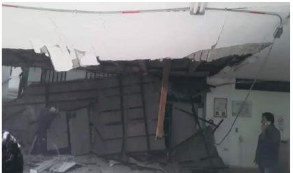
Se trata del techo del primer piso de la edificación que se vino al suelo sin que hasta ahora se establezca las causas de la falla en la estructura.
