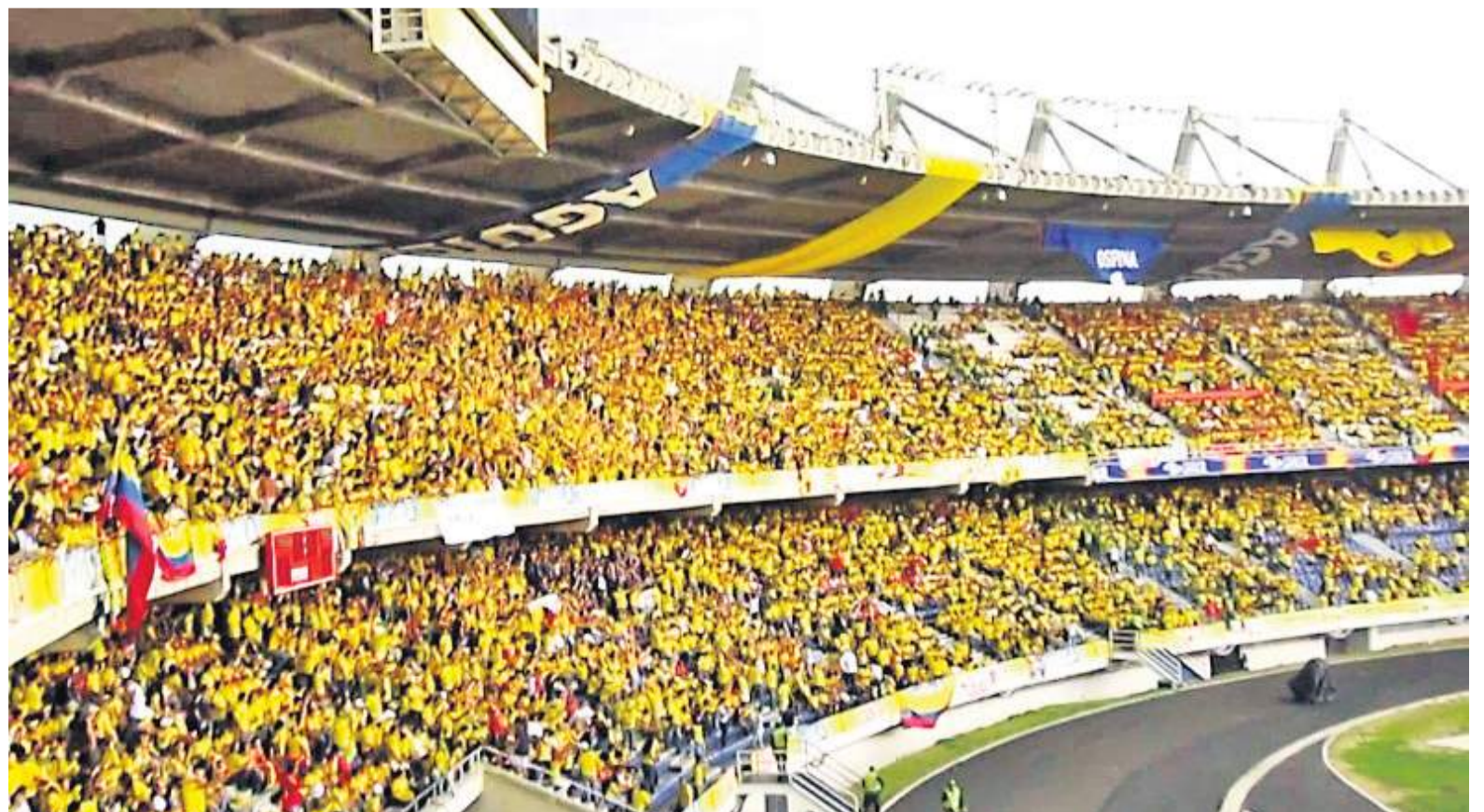
El ingreso al Metropolitano para ver los partidos de la selección estará condicionado a tener el carné de vacunación.
