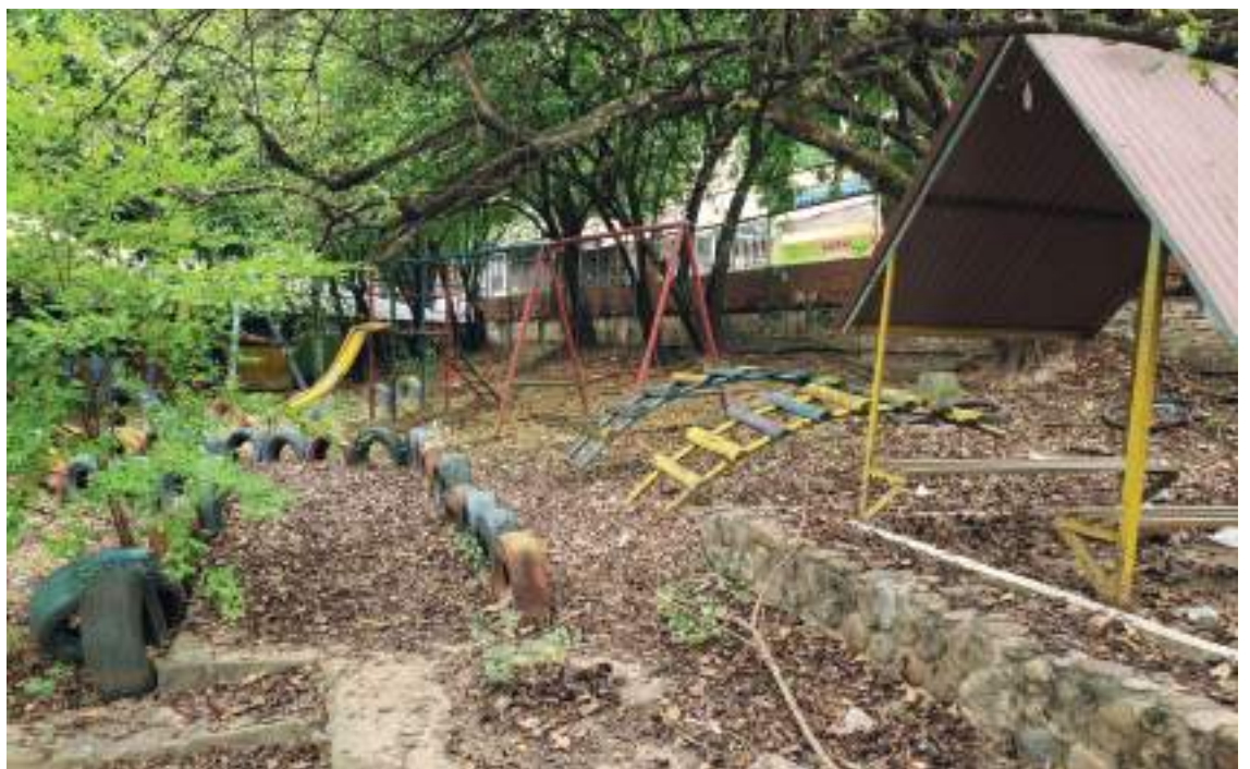
Así está la Sede Picardías del IPC, en el barrio Los parques, Comuna ocho de Neiva, en total abandono de los entes correspondientes.
