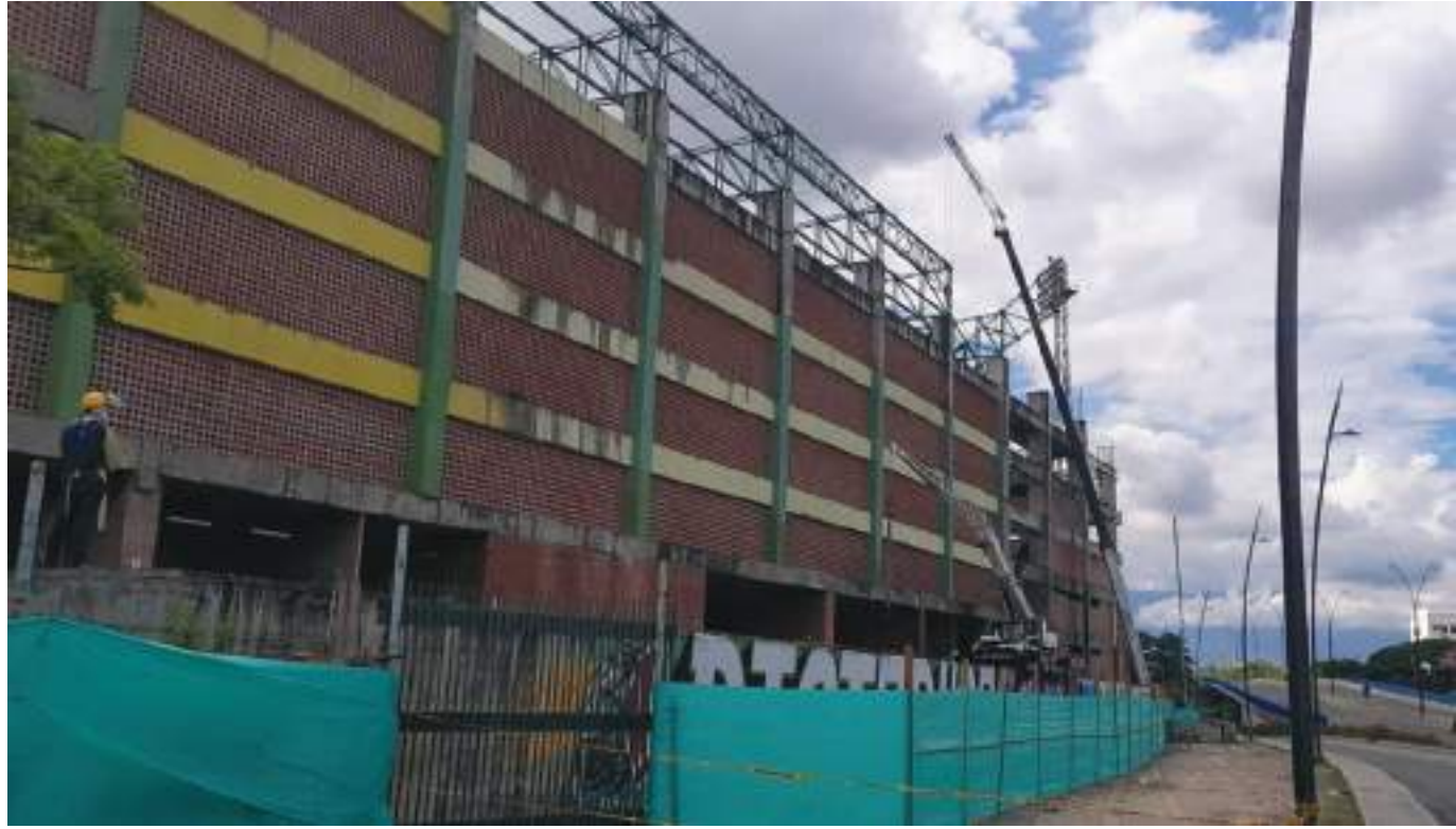
Luego de varios años se decidió reiniciar las obras de remodelación.
