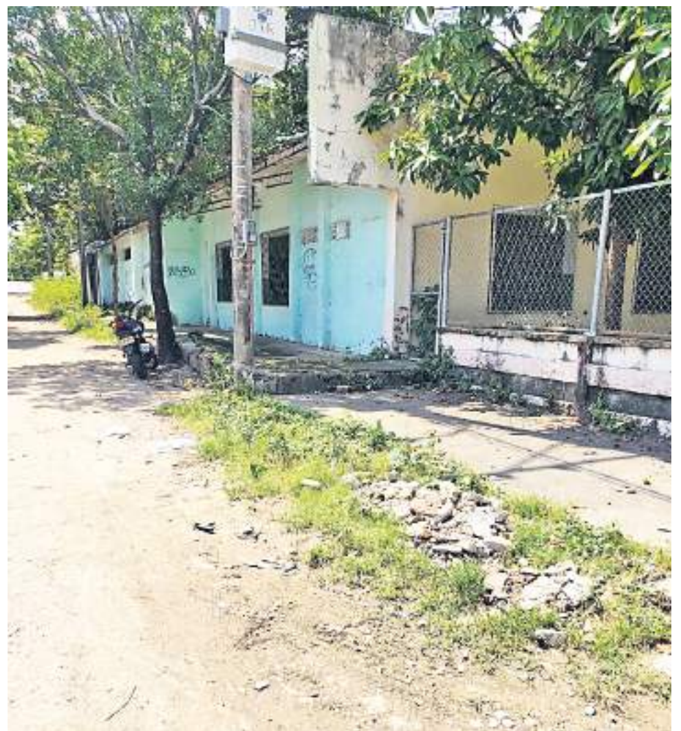
Realmente las vías en el ‘Rojas Trujillo’ están en mal estado.
