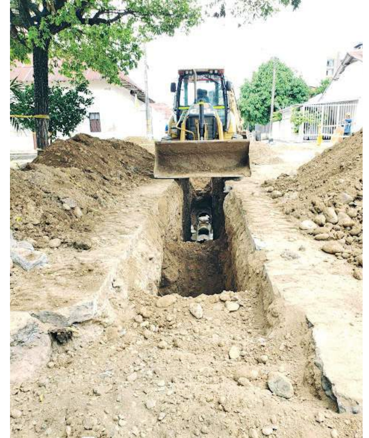
En las intervenciones se utiliza maquinaria pesada.
