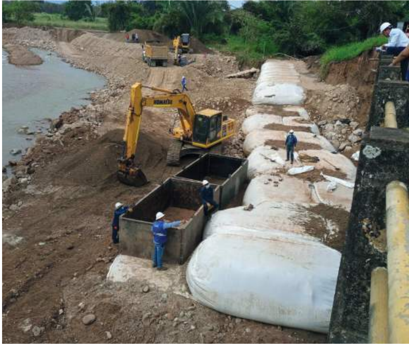
El Concesionario de la Ruta al Sur está estudiando la realización de un nuevo puente que comunicará la doble calzada de la vía Neiva-Rivera que tendría un valor aproximado de 6.000 mil millones de pesos.
