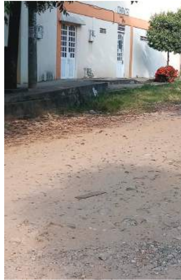
Realmente el estado de la vía es deplorable.
