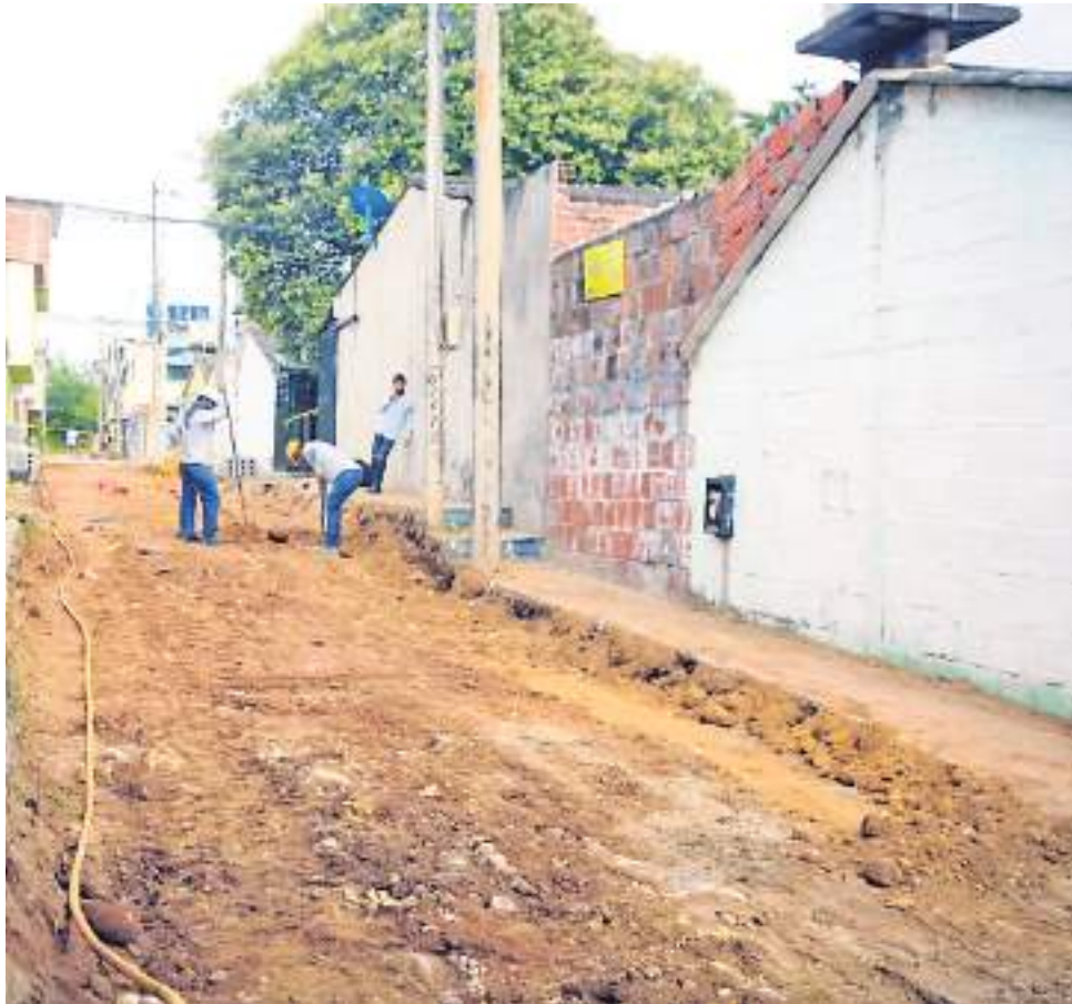
La administración les colabora con equipos, trabajadores y asesoría técnica.
