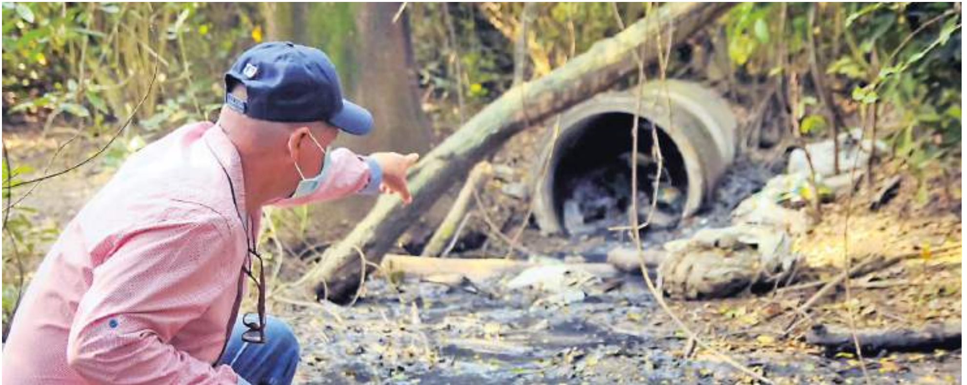
A la quebrada La Carpeta, son vertidas las aguas servidas del centro de abastos de Neiva, y va a desembocar al Río Magdalena.
