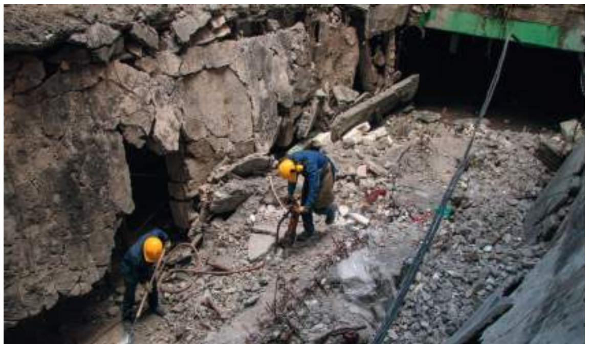
La administración municipal dio a conocer que oficialmente inician obras y vuelven los hinchas al estadio de Neiva luego de estar paralizadas por más de cuatro años
