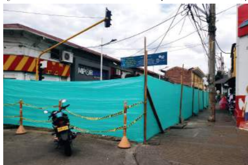
Cerramiento en la calle 8 con calle 6.
