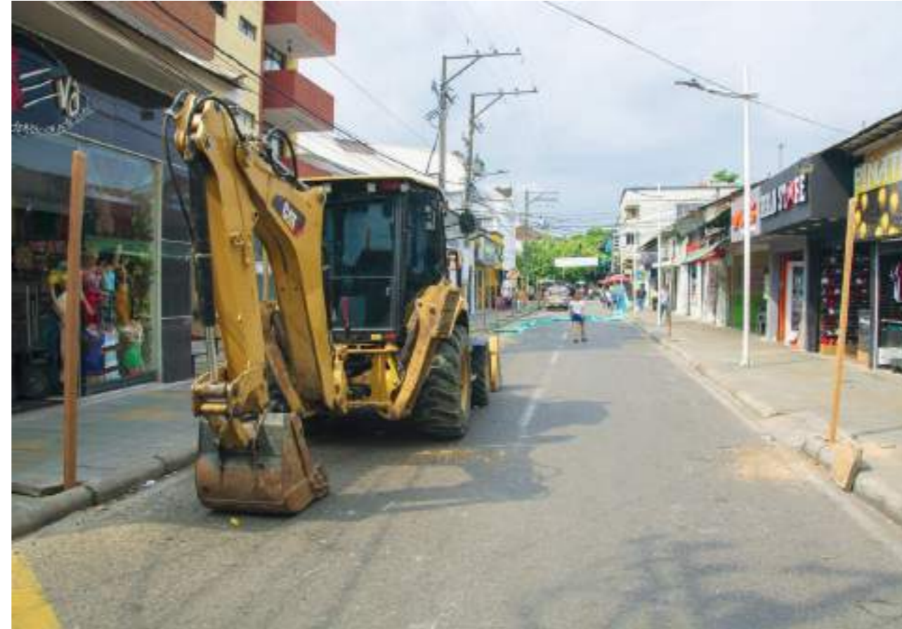
Los trabajos de cambio de acueducto y alcantarillado requieren maquinaria pesada.
