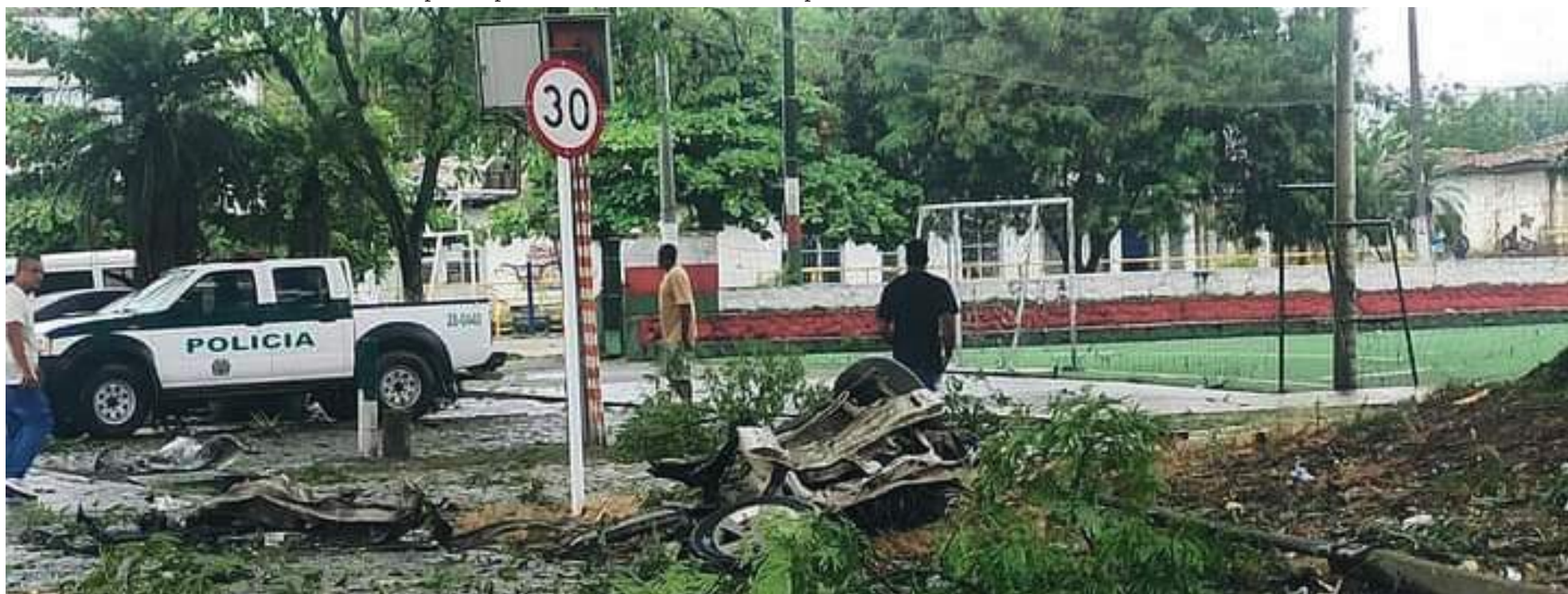
Como la iglesia, varias casas, locales comerciales y otras infraestructuras presentaron vidrios rotos y destrucción de algunas fachadas.
