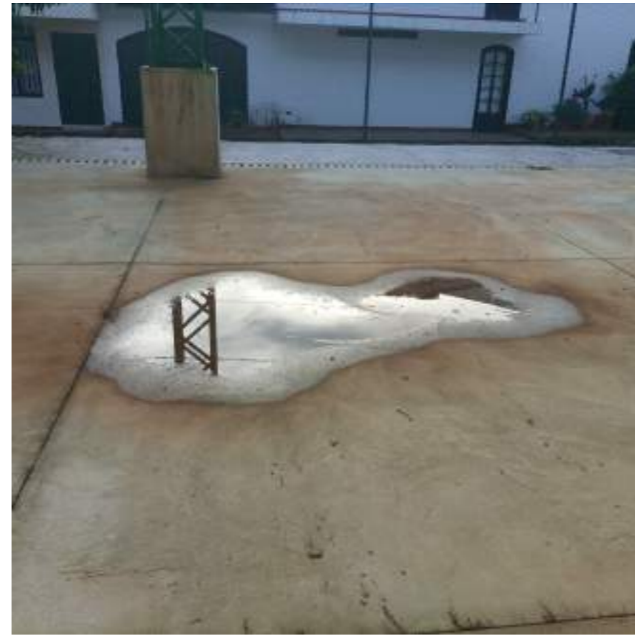
Canal que se deterioró con las fuertes lluvias presentadas en los últimos días. Charcos se forman en la cancha debido a que no cuenta con un desagüe de aguas lluvia debidamente instalado.
