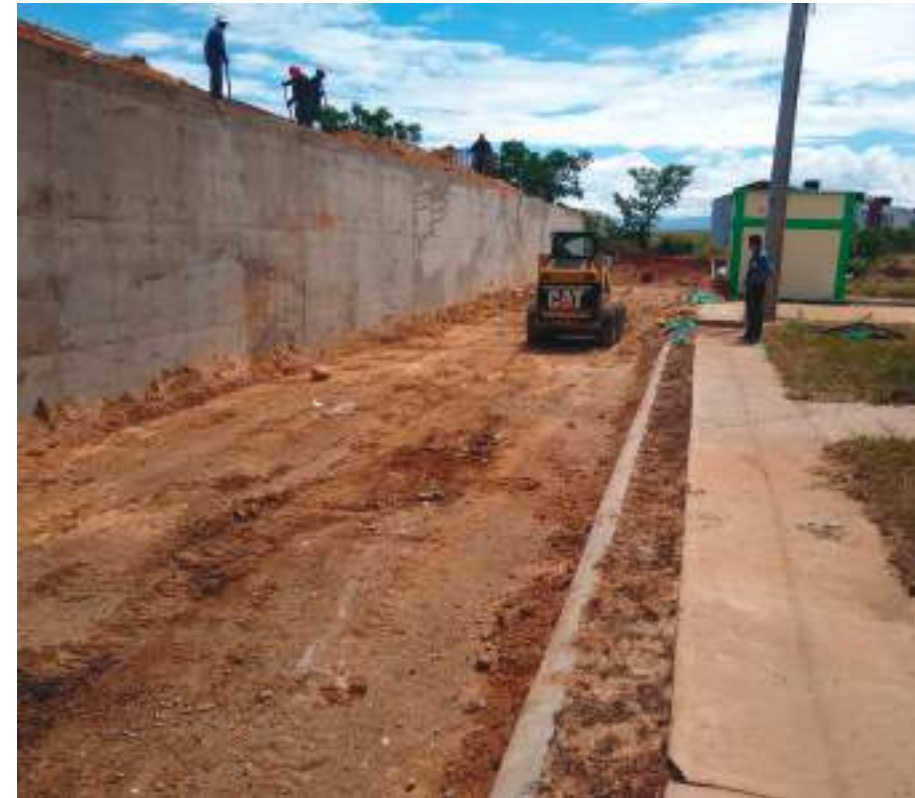
La calle aledaña al muro también se está interviniendo.
