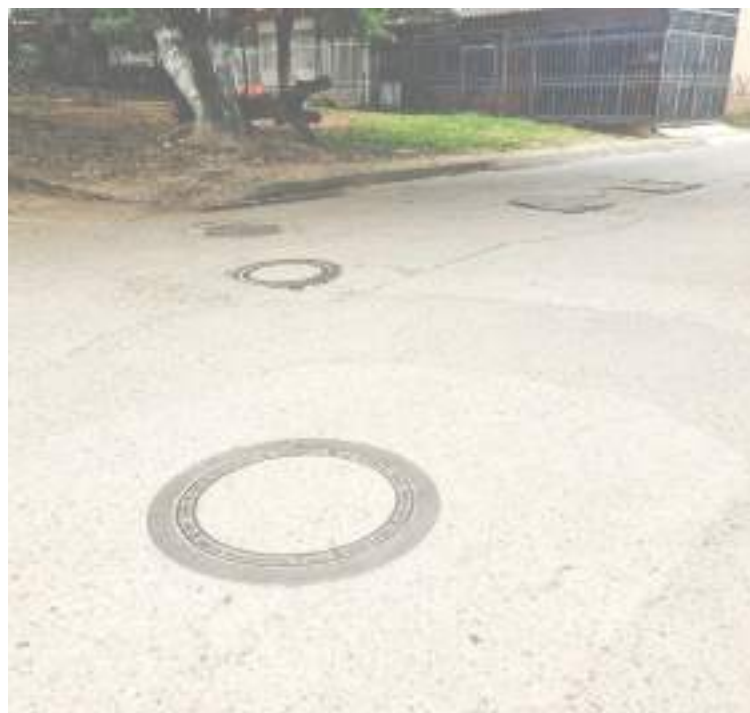
Igual sucede con las tapas de las alcantarillas, se espera seguir restituyéndolas en plástico o madera.
