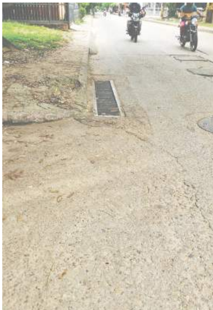
Algunas rejillas han sido restituidas en metal, pero la idea es llegar a material plástico para acabar con la tentación de los robos.
