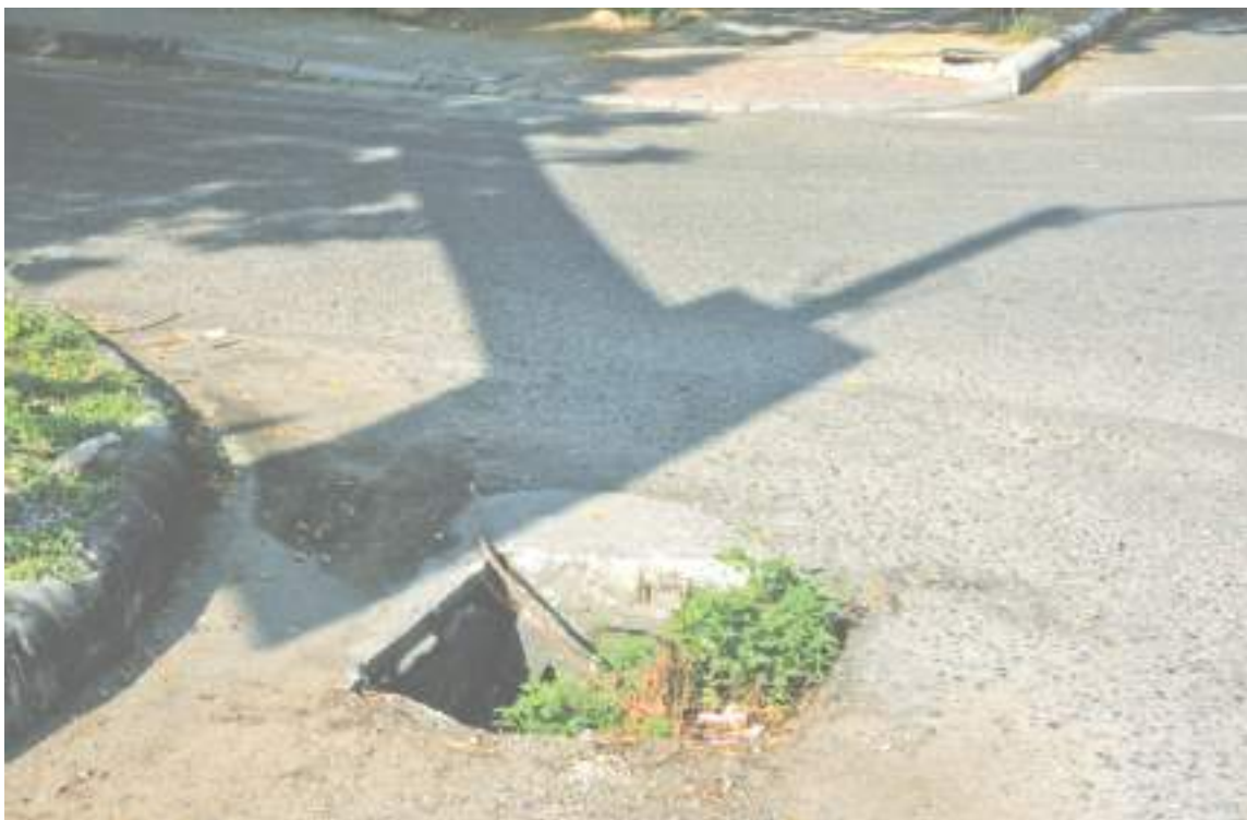
Huecos como el que queda con el robo de la tapa son verdaderas trampas para peatones y conductores.
