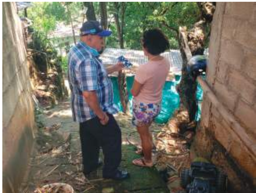
Zaguán de ingreso a la zona en donde está ubicada la vivienda colapsada
