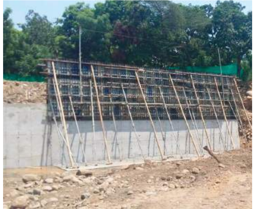
La octava fase tendrá un muro de 113 metros longitudinales de contención en concreto reforzado, sobre la margen derecha del río Las Ceibas.
