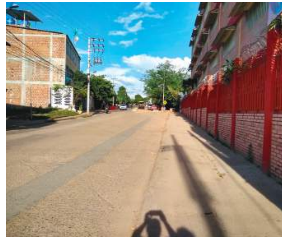
Los trabajos en la avenida de la Orquídea en la carrera 31 con calle 19.
