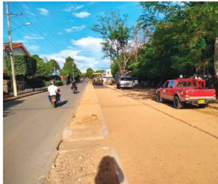
La pavimentación en asfalto se realizará en los dos carriles.
