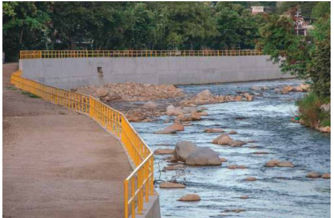
Estas obras se hacen con el fin de mitigar daños ocasionados por el desbordamiento del río.
