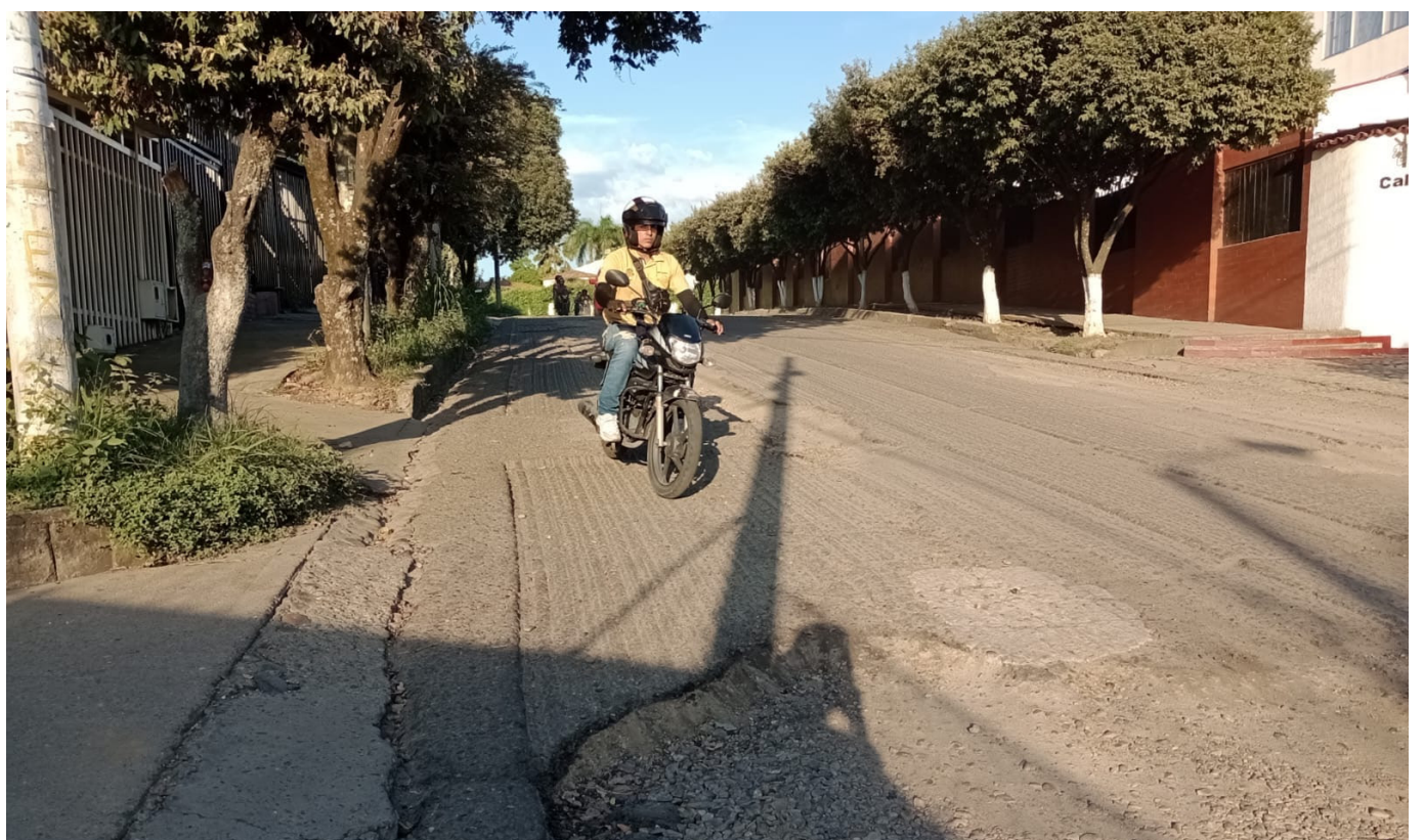
Calle 4 # 30 C, barrio Los Parques.
