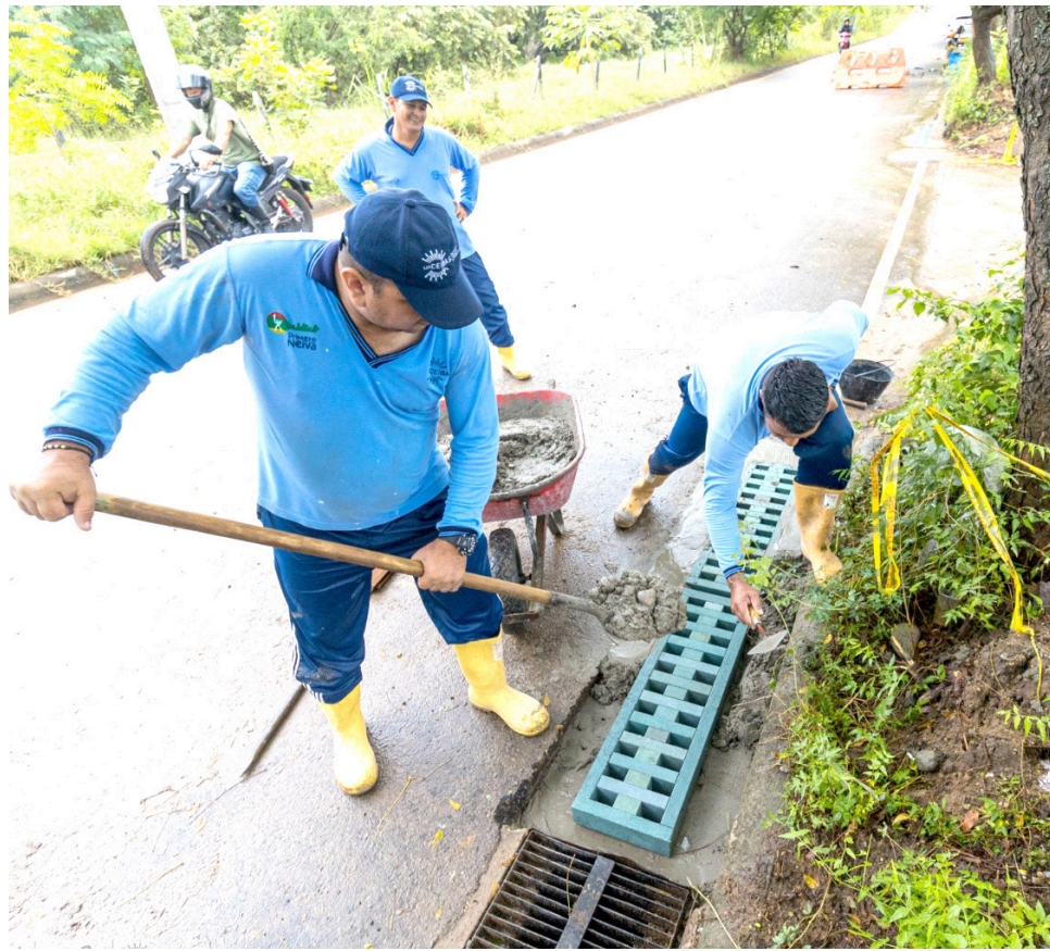
Ya comenzó la instalación de estas nuevas alcantarillas.
