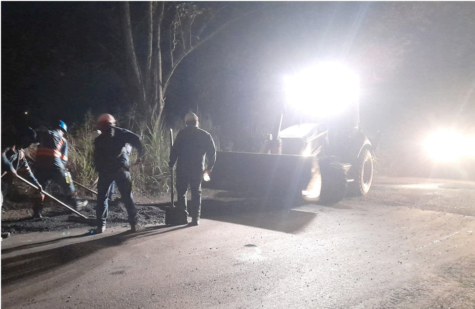
Durante la intervención del primer tramo, el pasado 3 de abril, los trabajos se extendieron hasta altas horas de la noche.
