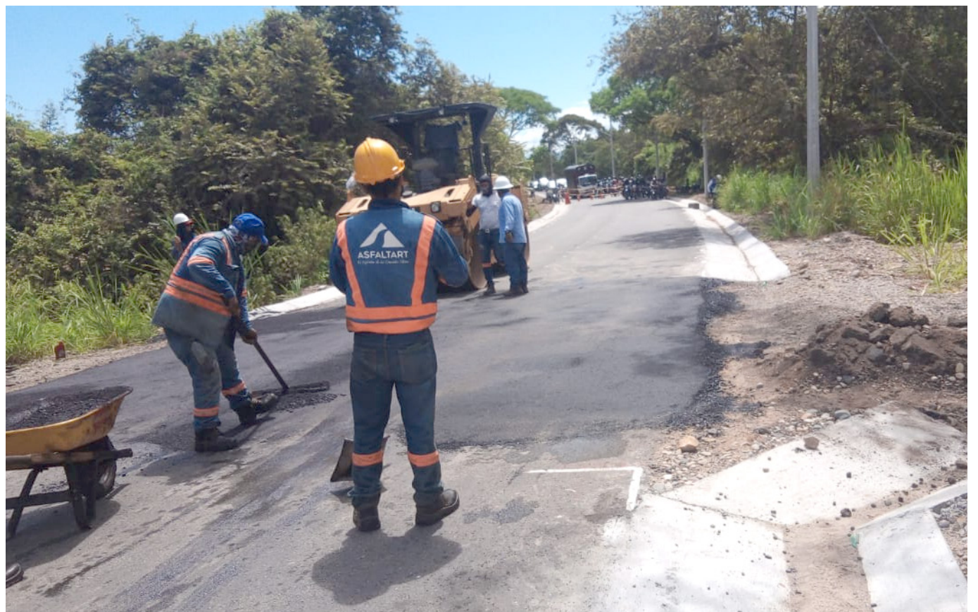
Con recursos donados por las comunidades de Palermo y Santa María se avanza en la pavimentación y reparcho de algunos tramos en la vías Neiva - Palermo.
