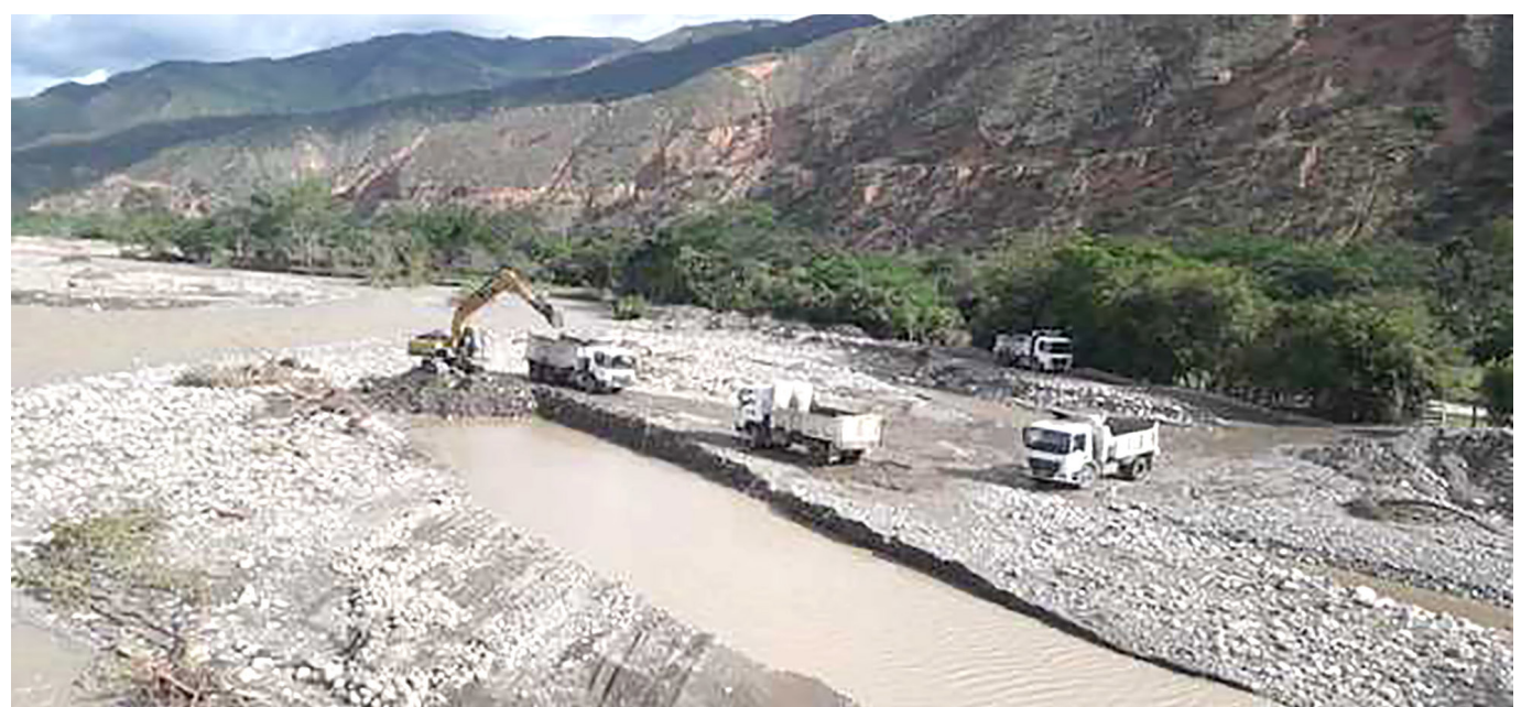
Maquinaria de la gobernación canalizando el río Ambicá
