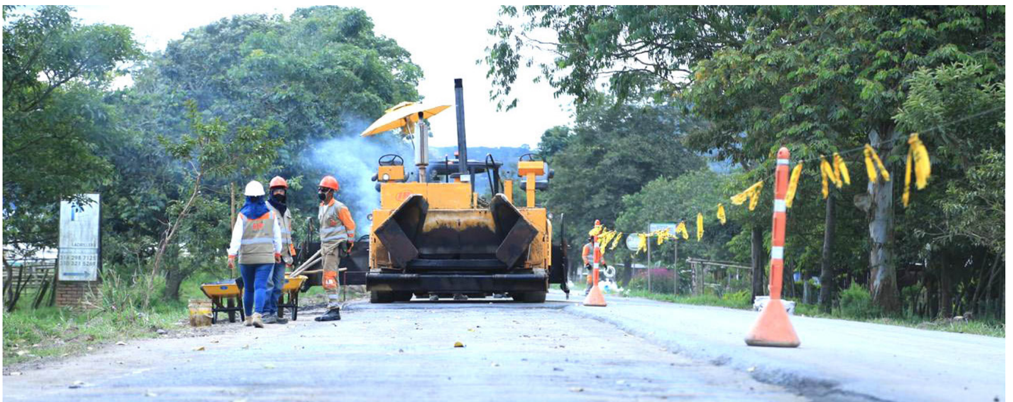
Ya se ven avances en la vía al sur.
