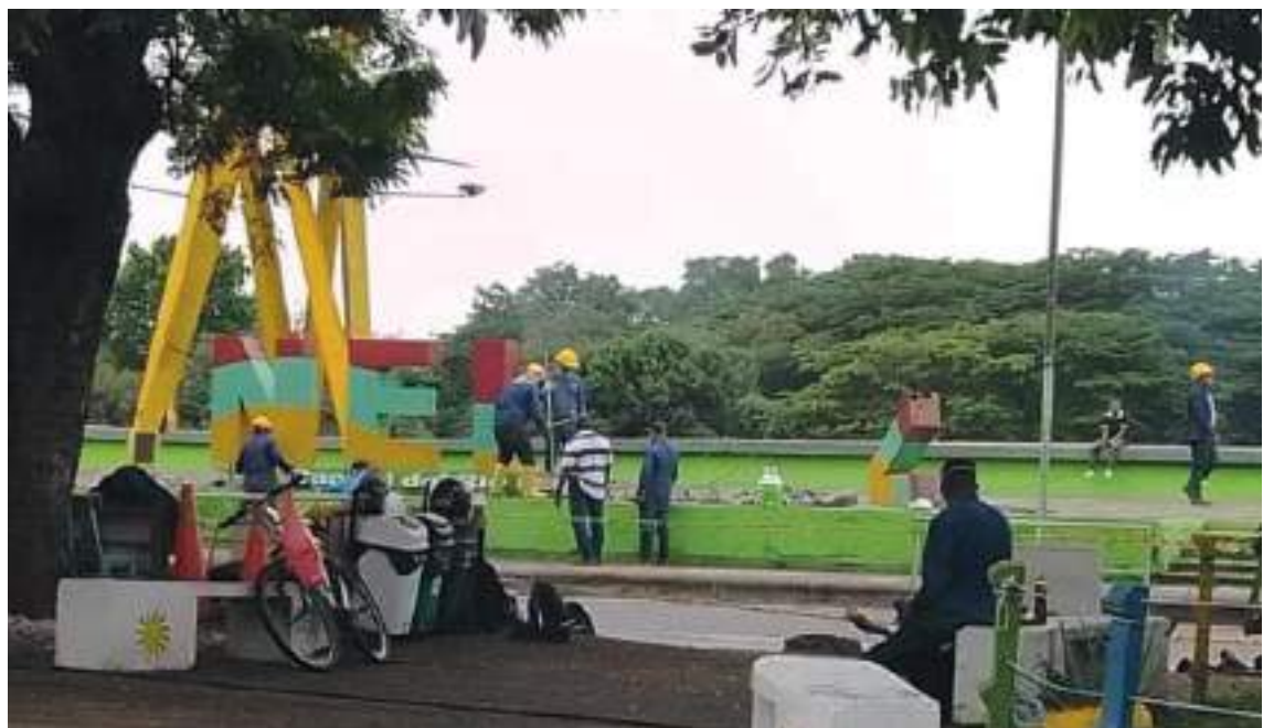
Los neivanos observaron la desinstalación del letrero de 'Neiva' que se ubicaba en el monumento a La Gaitana. Ante el interrogante de los neivanos, el alcalde Gorky Muñoz explicó en sus redes sociales, que se trata de un cambio de imagen que debe darse para posicionar la marca internacional de la ciudad.
