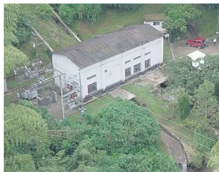
Central Eléctrica La Pita.
