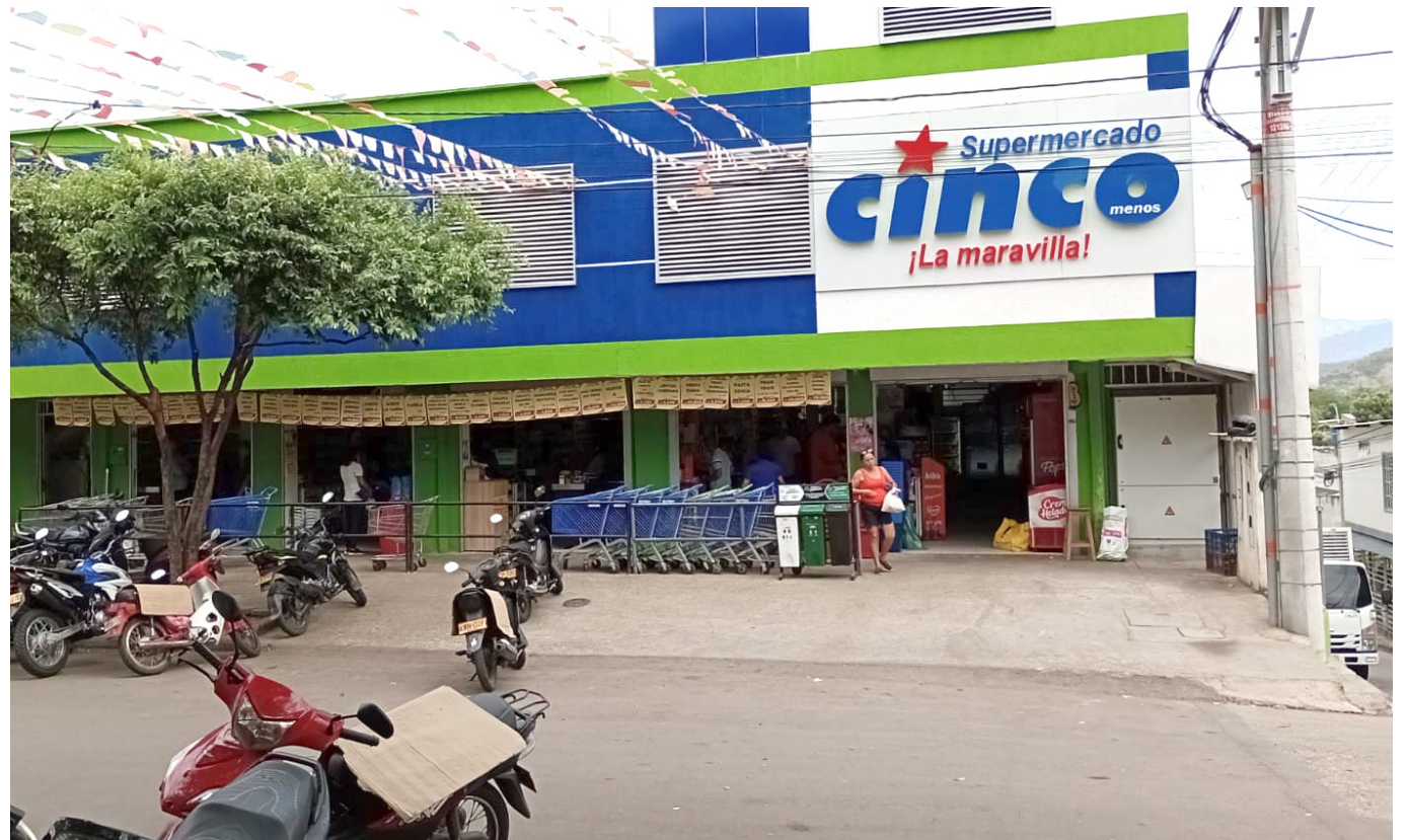
Local comercial afectado por la explosión.
