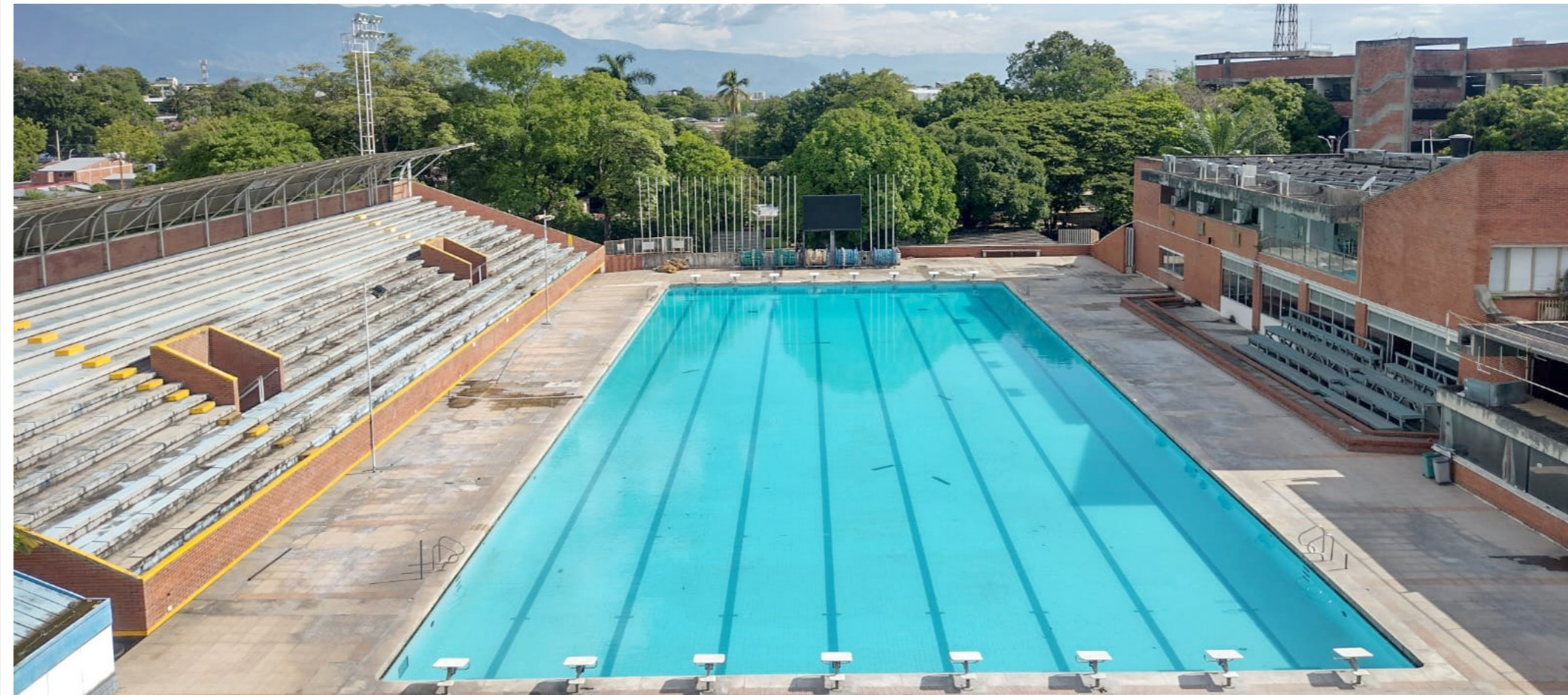
Piscina Olímpica de Neiva.
