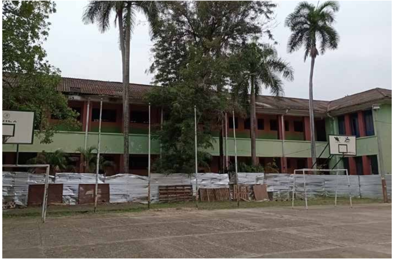
Hay $1.000 millones para Infraestructura Educativa.
