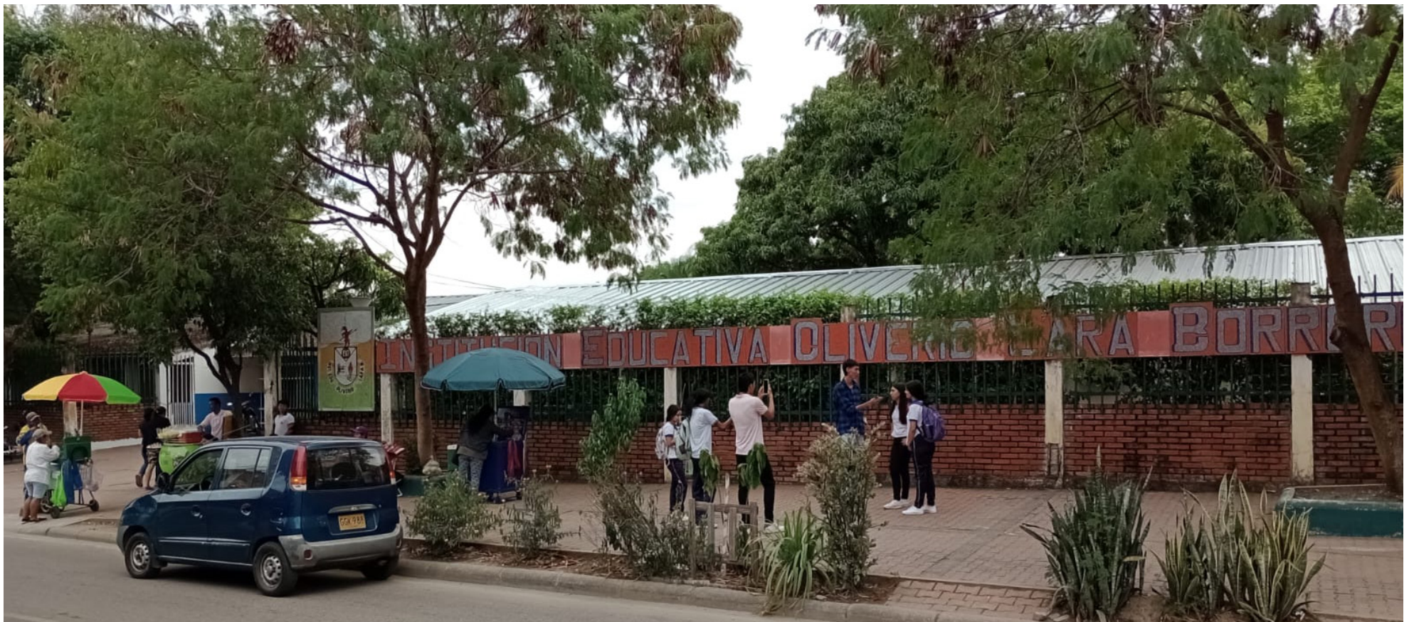
El Colegio Oliverio Lara, se inunda en temporada de lluvias por la falta de construcción de una vía.
