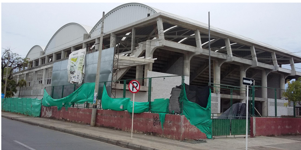
Entre las obras sin terminar hay parques, colegios, centros hospitalarios, viviendas de interés social, entre otras.
