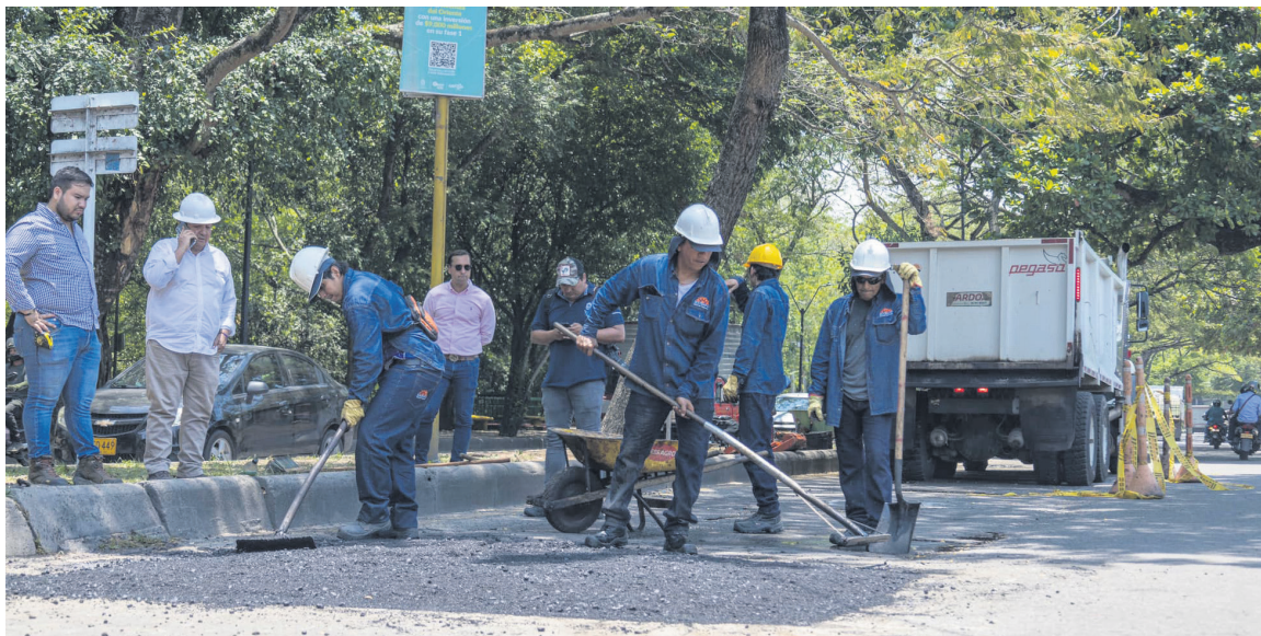
La Alcaldía de Neiva, en cabeza del ingeniero Germán Casagua, comenzó la recuperación progresiva de la malla vial para el municipio de Neiva.
