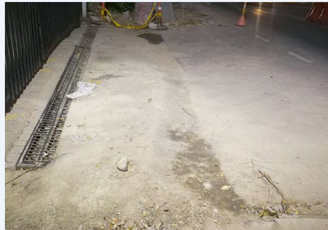
Frente a las viviendas se encuentran aún los rezagos de la intervención de la vía nacional.
