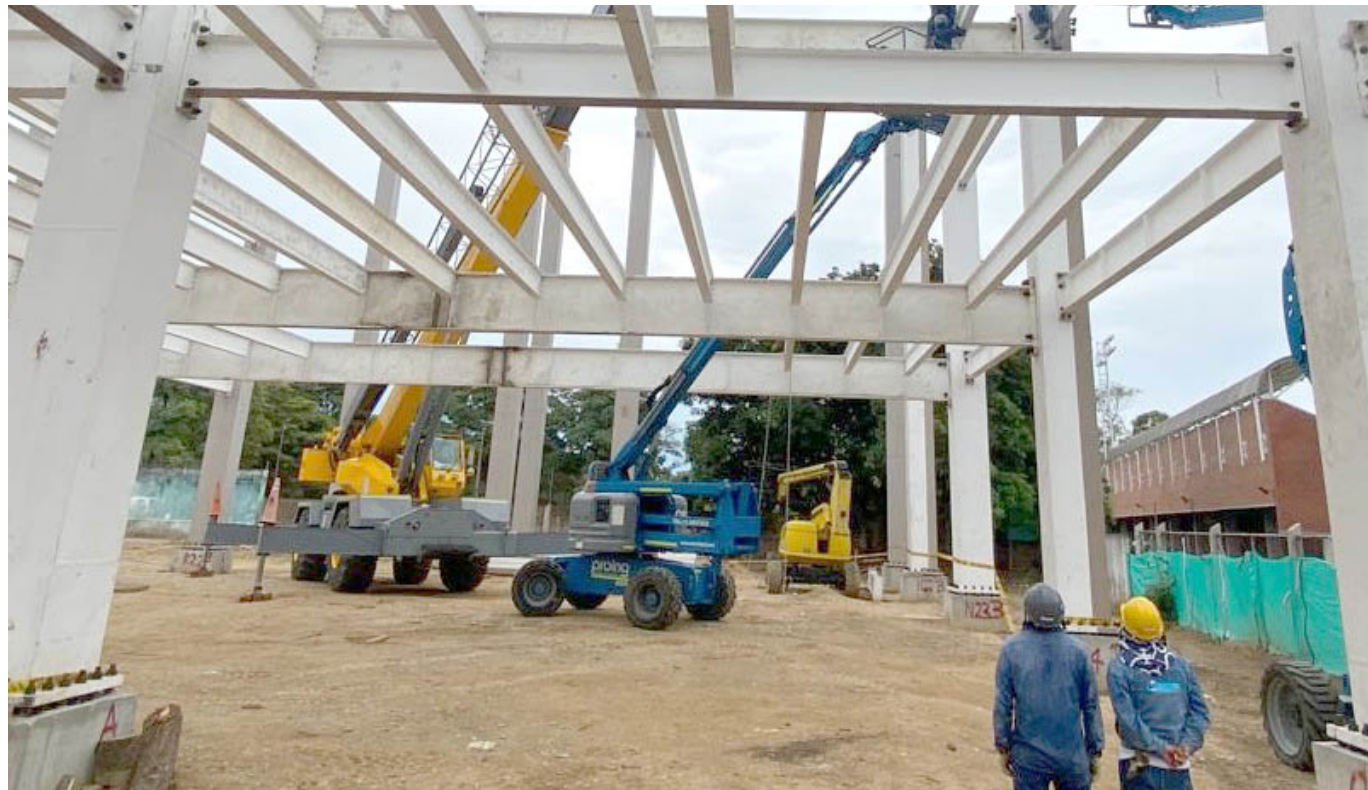
Construcción del Centro de Alto Rendimiento deportivo en Neiva.
