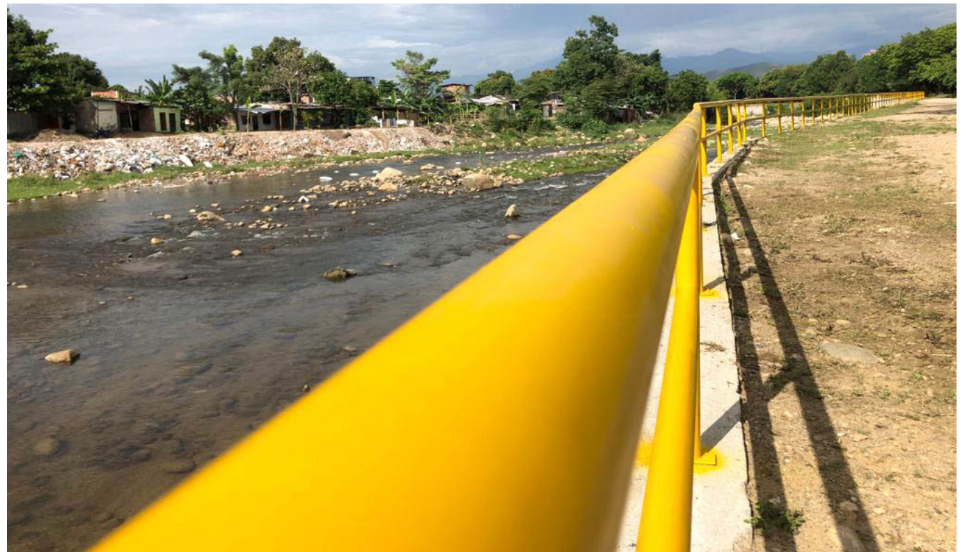
La canalización de la fase nueve, comienza cuando ya se consigne los recursos.
