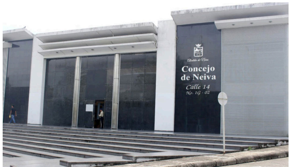
Nuevo crédito de tesorería por $30 mil millones para lograr cumplir con el pago de cuentas de contratistas y proveedores que adeudan
