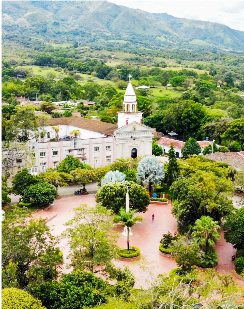
El municipio de Tesalia tendrá un nuevo acueducto con inversión de la Gobernación del Huila.
