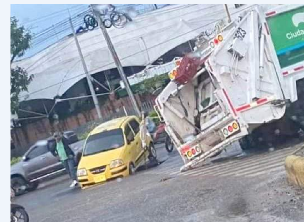
Dos carros afectados por hundimiento de la vía en la carrera 16.
