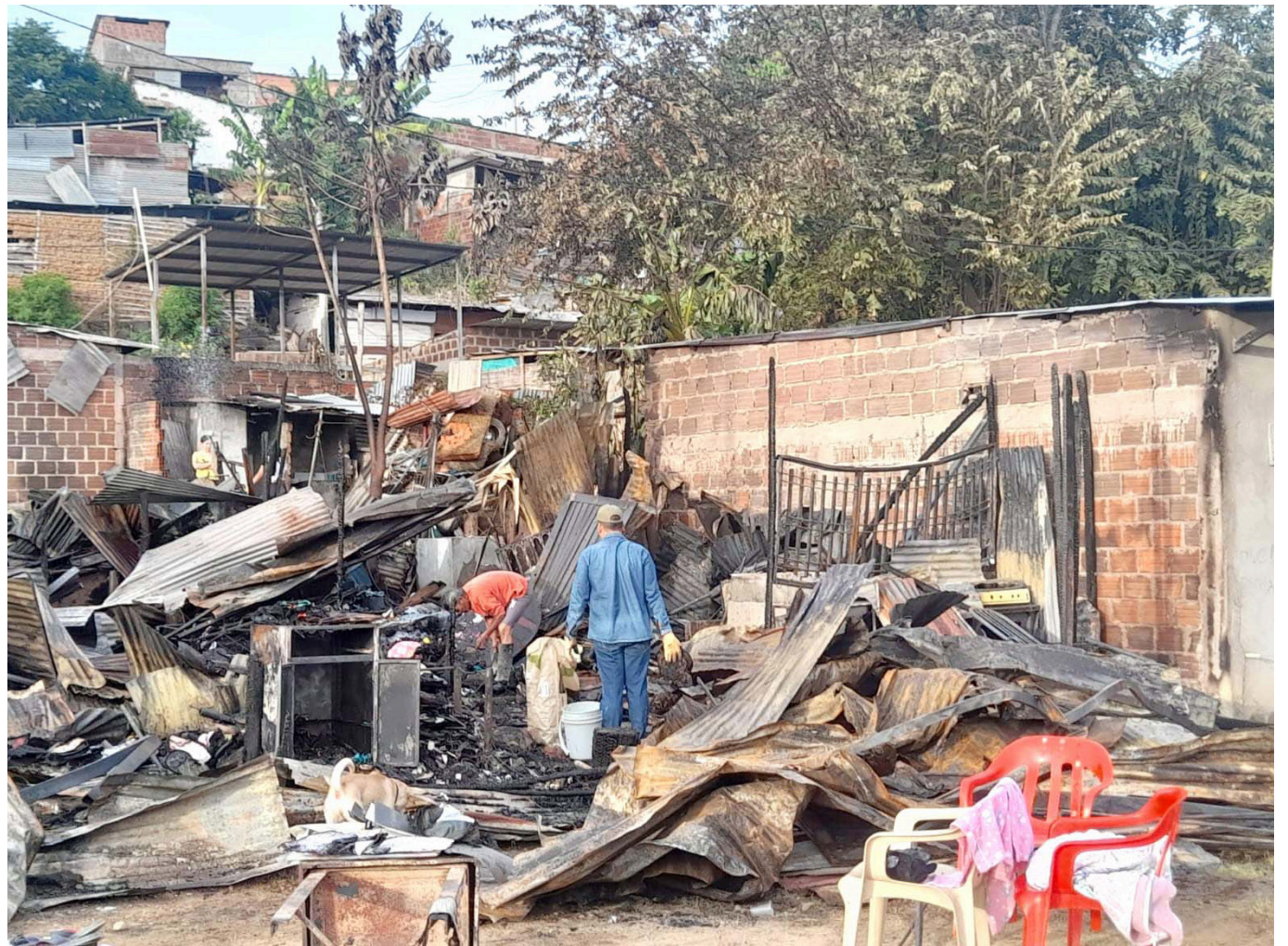
Viviendas destruidas tras el incendio en el barrio Oro Negro
