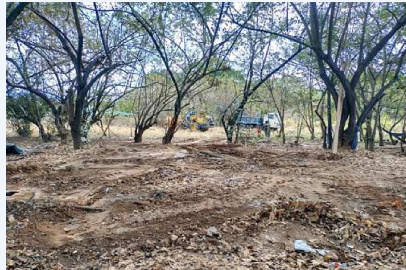
Con maquinaria se debió tumbar construcciones que se pretendían realizar.
