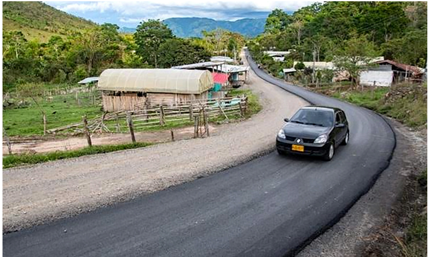
Luego de la consecución de recursos para la construcción de los tramos viales faltantes fue adjudicada y contratada.
