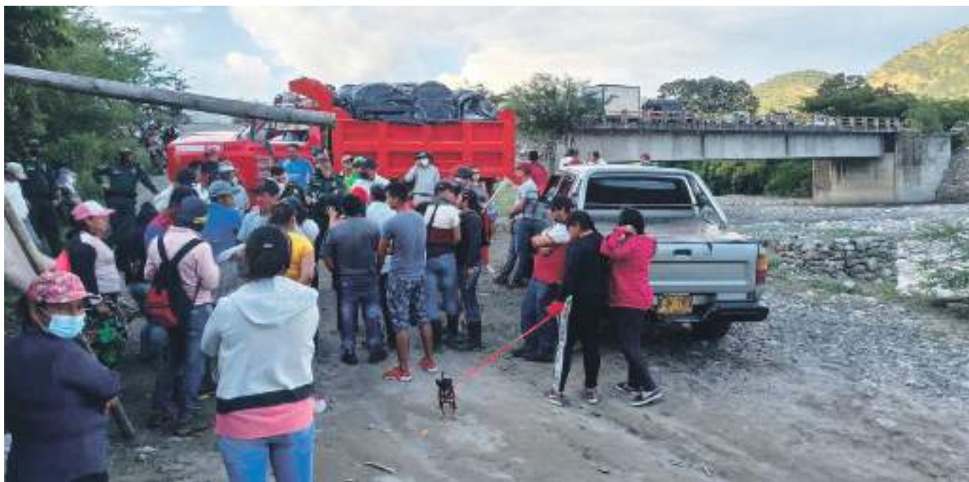
Habitantes del municipio de Colombia se sienten inconformes por el estado del puente Totumo.
