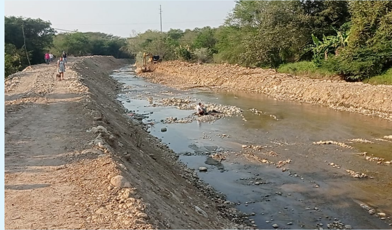
Esta fue la obra construida por la anterior Alcaldía Municipal.
